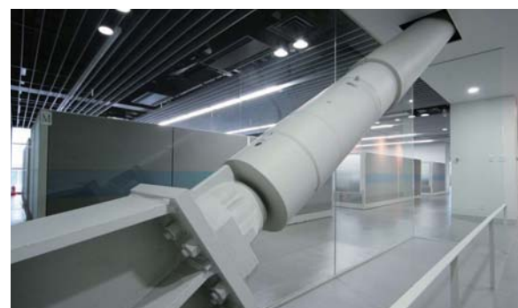
制震ダンパーが工場内に約570台配置され、地震による衝撃を吸収する
