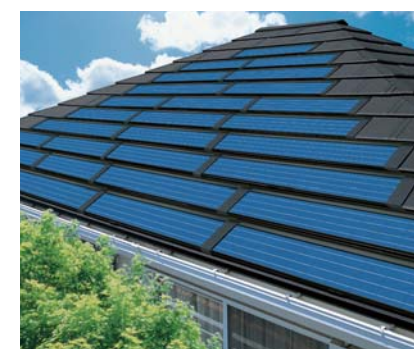
金属屋根一体型太陽光発電システム
