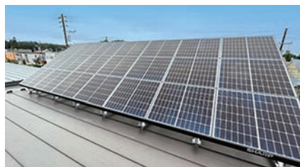
5.43kWシステム (北海道)
