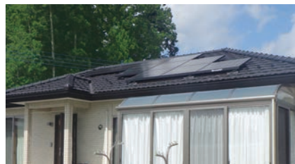
3.64kWシステム (栃木県)
