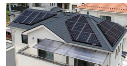
■ 2.98kWシステム (奈良県)
