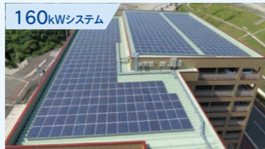
浅井建設株式会社様 ふじ台ステーションビル(立体駐車場)(和歌山県和歌山市)
