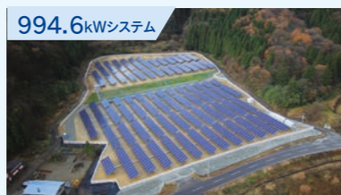
文化シャッター株式会社様 西山太陽光発電所(新潟県柏崎市)
