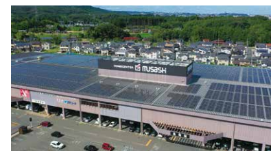
屋根設置（ホームセンター）
