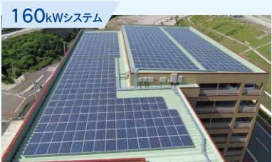
浅井建設株式会社様（ふじ台ステーションビル（立体駐車場）（和歌山県和歌山市）
