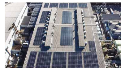
屋根設置（工場）
