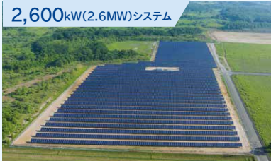
シャープ苫小牧第一太陽光発電所（北海道苫小牧市字柏原）
