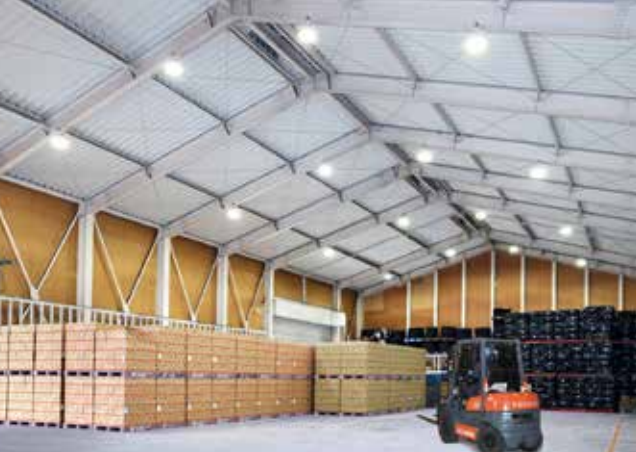
[高天井照明] JA えひめ物流株式会社様（愛媛県松山市）
