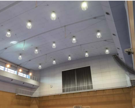
シャープ総合開発センター(天理事業所)内 天理スポーツセンター
