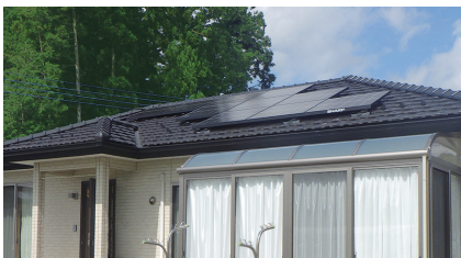
3.64kWシステム (栃木県)
