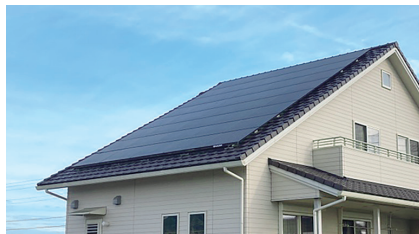
8.80kWシステム (茨城県)
