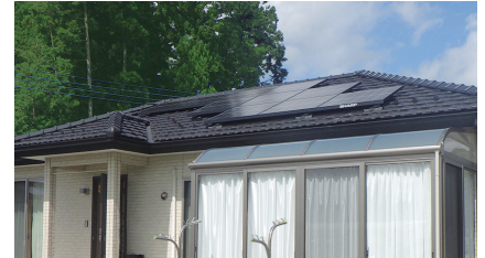
3.64kWシステム (栃木県)
