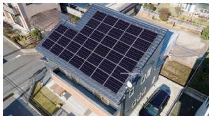
9.21kWシステム (茨城県)
