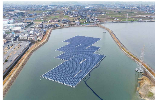
景観に配慮して美しく設置できた点を高く評価
