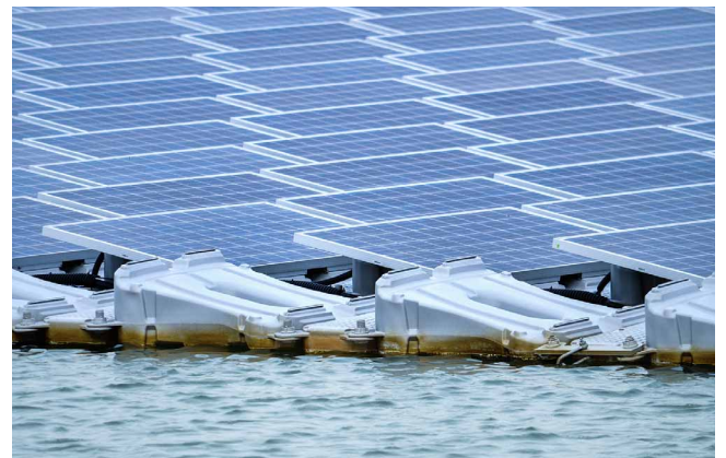
ソーラーパネルをフロートに固定して水上に設置
