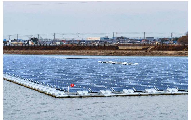
水上なので建造物で遮られることなく、十分な太陽光を受けられる
