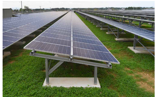
最大約160メートルに渡ってソーラーパネルを設置し、クローバーで地面を緑化し反射熱を軽減
