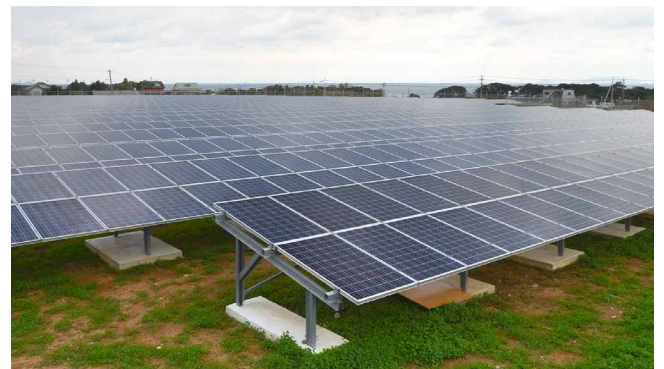
公称最大出力245Wの高出力多結晶モジュールを、南向き・設置角10度で敷設
