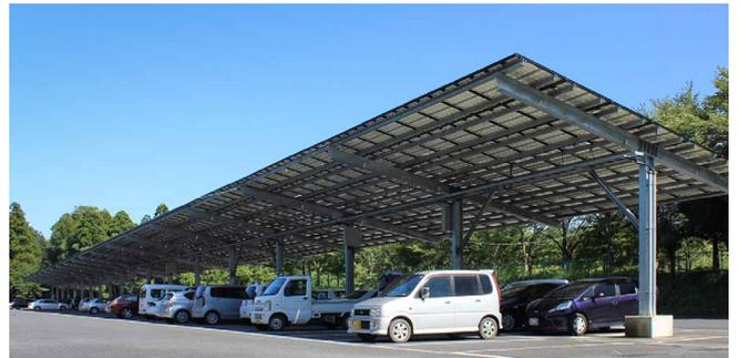
熱がこもりにくい架台設計により、2013年は8月が発電量最大に
