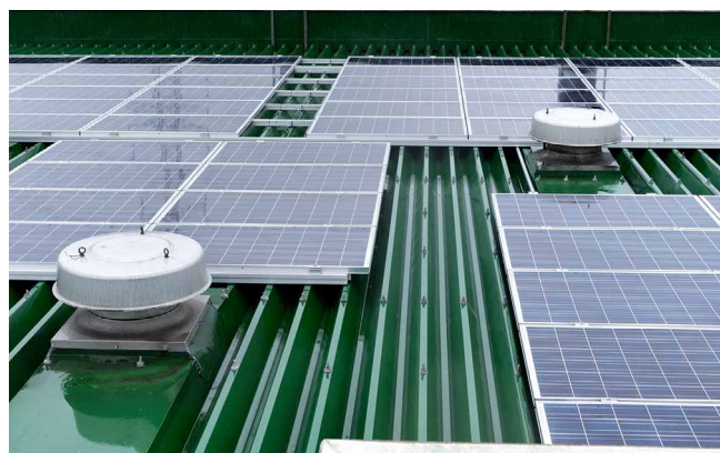
工場の折板屋根にソーラーパネルを設置
