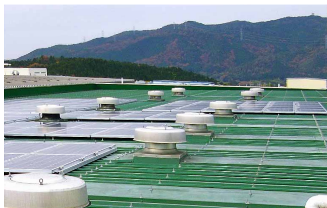
設置スペースには十分余裕があり、さらなる増設も検討されている
