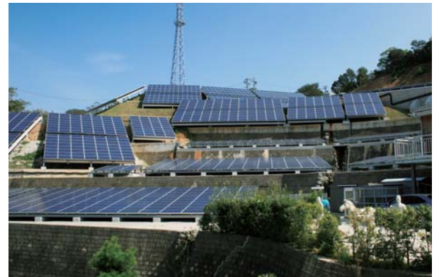
斜面に沿って大小さまざまな太陽電池アレイを設置、 大規模な造成工事を行わずに工事費用を削減
