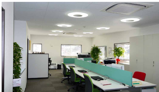
事務所内にLEDシーリングライトDL-C501Dを20台設置
