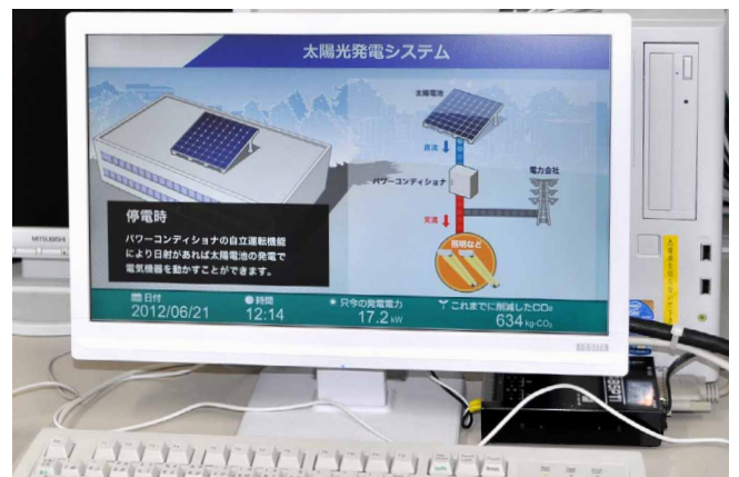
制御室に設置した電力モニターで発電状況をチェック
