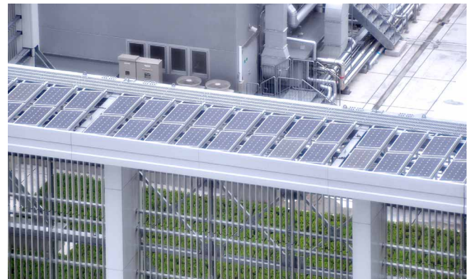
高さ100mに強風に強い高所向けモジュールを設置
