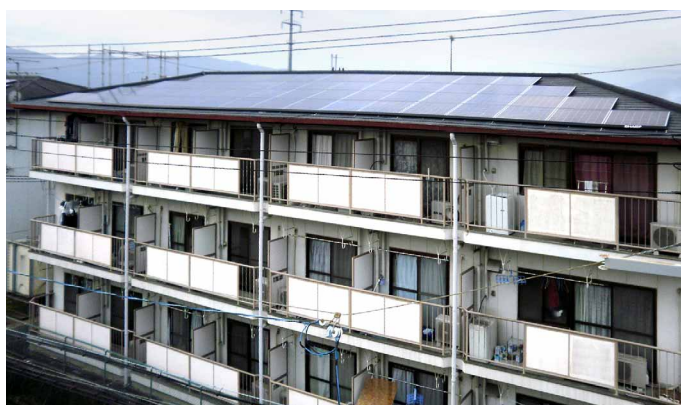
「コーポ朝倉」のスレート屋根に56枚の太陽光発電パネルを設置
