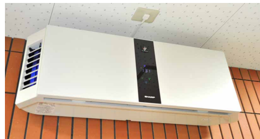
機器設置を見込みあらかじめ天井に電源を確保
