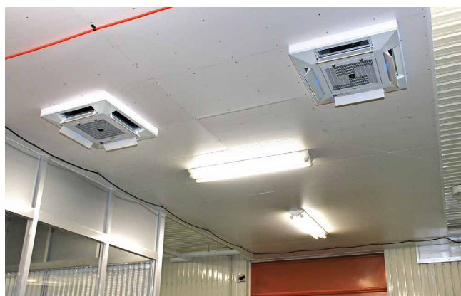
魚卵の加工製品を仕上げるパッキング室
