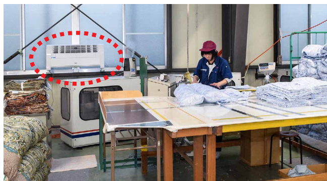
静電気が作業の妨げになる羽毛充填場にも床置き型を設置
