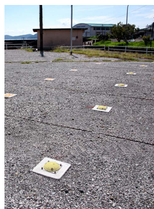
駐車位置に在車センサーを設置
