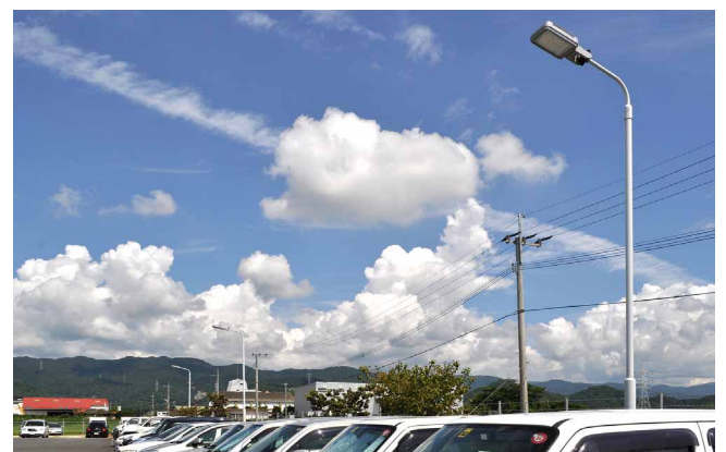
本社駐車場にはヤード灯を導入
