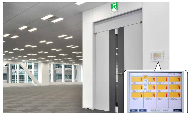
オフィスのドア横に制御パネルをつけ、より高い節電効果を
