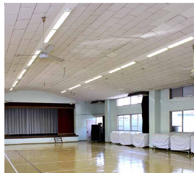
運動やレクリエーションで使用される多目的のホール。天井高が約7mで管球交換が難しく、長寿命のLEDが大きなメリットになった
