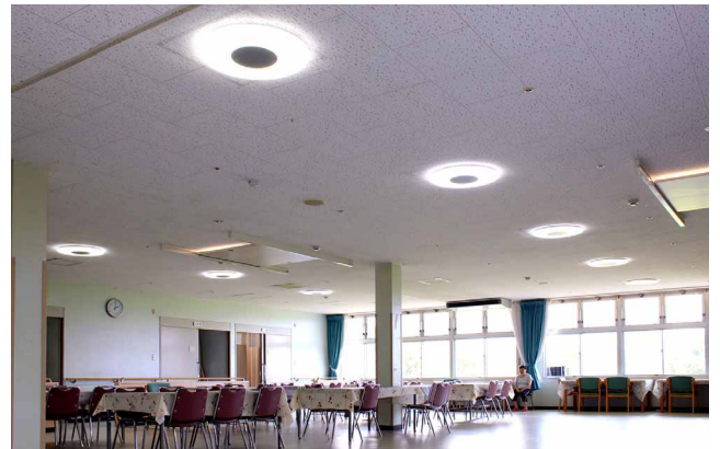
病室だけでなく、デイルームにもLEDシーリングライト。外光が差す窓側はエコセンサーにより自動で照度が抑えられる
