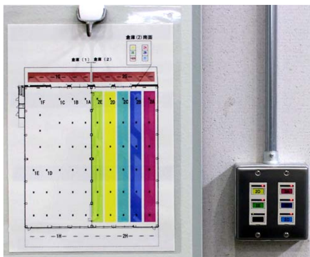
列ごとにスイッチを色分けし、作業しないときにはこまめに節電対応。ON/OFFの繰り返しに強く、すぐにフル点灯するLED照明のメリットを生かされている
