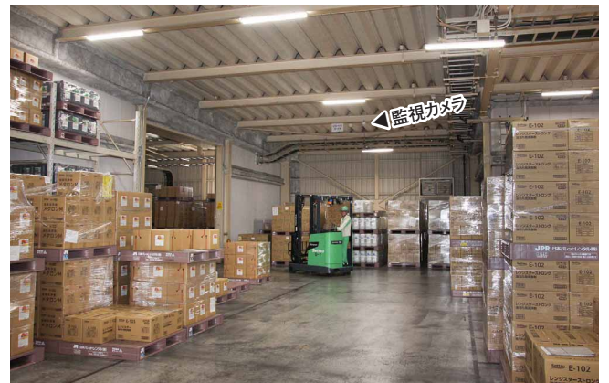
天井が高く広い空間でも監視カメラが動体検知、照明を自動制御
