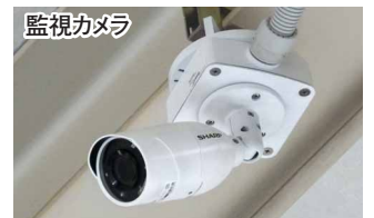
天井が高く広い空間でも監視カメラが動体検知、照明を自動制御
