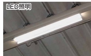
天井が高く広い空間でも監視カメラが動体検知、照明を自動制御
