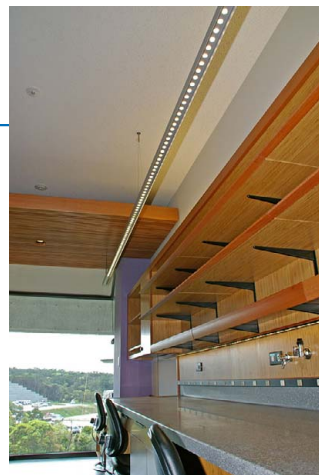
ライン型LED照明・吊り下げ
