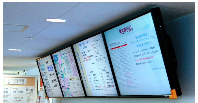
共信コミュニケーションズさまの設置工事により、学生用ラウンジの壁に掛けた4面マルチのラインもすっきりおしゃれに
