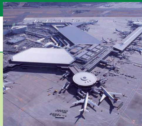
所在地：千葉県成田市 写真提供：成田国際空港株式会社
