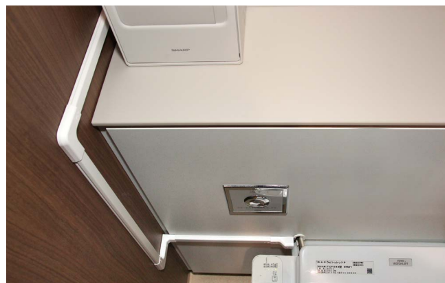
温水洗浄便座用の配線孔から電源を確保、配線はモール処理
